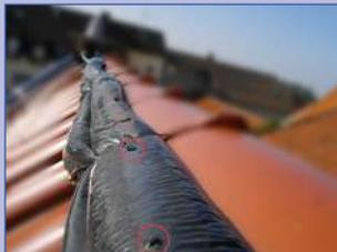
Bereits nach einer Saison mit Wasser vollgelaufen. Dämmwirkung gleich null.
