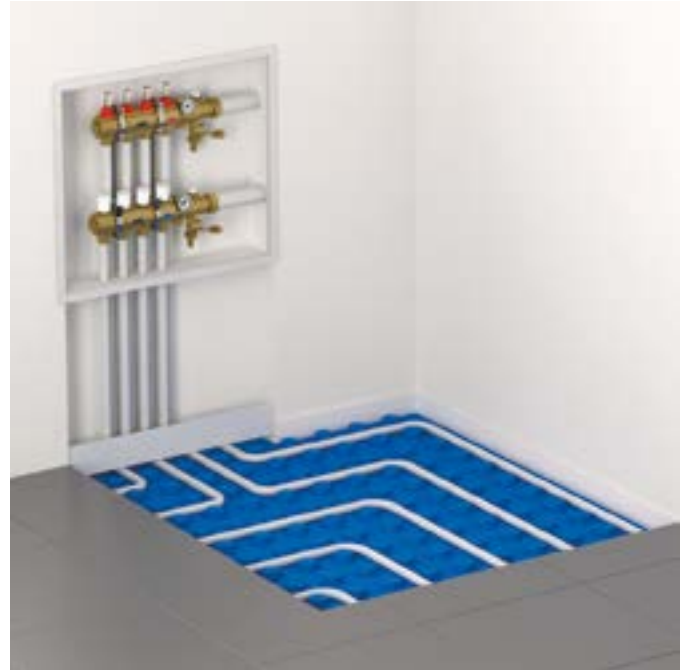
Fußbodenheizungsanlagen mit Mehrschichtverbundrohren installiert
