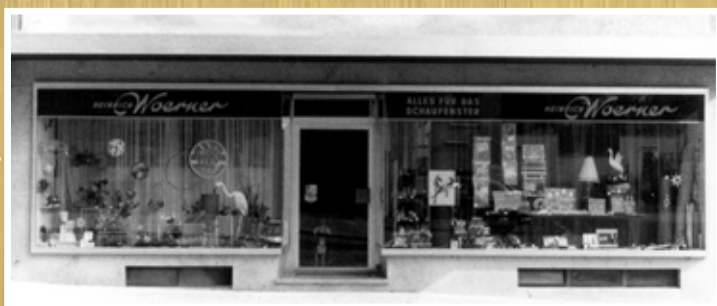
1963 Ladengeschäft in der Kramstraße nach dem Umbau
