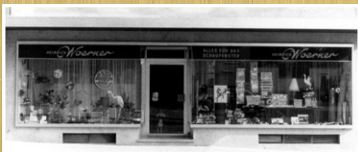
1963 Ladengeschäft in der Kramstraße nach dem Umbau
