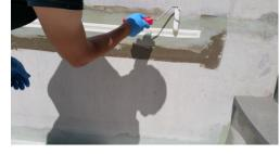
Mit EP43RV Reaktiv-Verdünnung können Sie bei Bedarf die Viskosität einstellen und damit die Grundierung etwas dünnflüssiger machen. Maximale Zugabemenge 10% (Gewichtsanteil).
