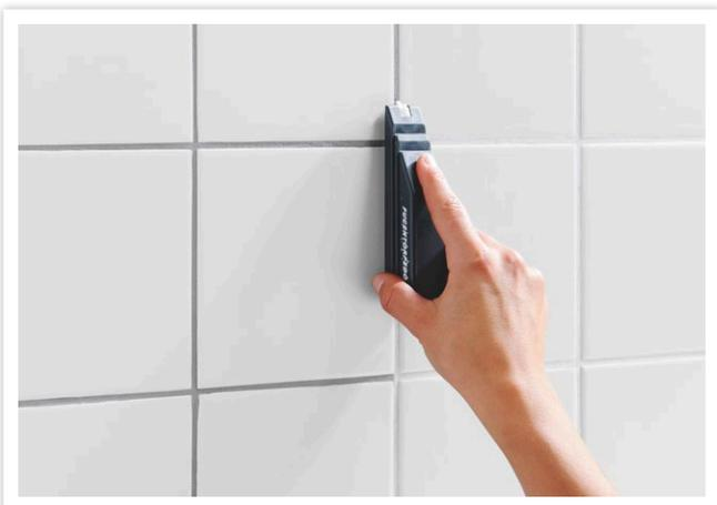
Schleifen Sie die Fuge mit dem Schleifsteg gründlich ab. Dabei bewegen Sie den Fugentorpedo mit ruhiger Hand und leichtem Druck langsam in der Fuge hin und her. Der Steg sollte dabei immer exakt in der Fuge liegen. Oberflächliche Verschmutzungen werden gelöst. Entfernen Sie den Schleifstaub und arbeiten Sie, wenn nötig, etwas nach. Jetzt ist die Fuge bereit für die anschließende Reinigung.
