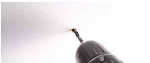
Abstand der Bohrungen am Panel untereinander ermitteln und an die Decke übertragen / mit Durchmesser 5,5 mm 4 Löcher in Decke bohren
