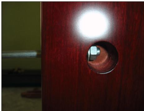
Stecken Sie die Bolzen in die dafür vorgesehenen Bohrlöcher und ziehen Sie die Muttern leicht an.
