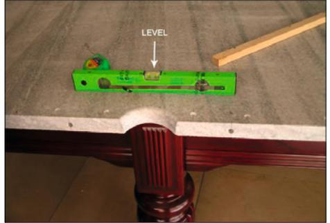
Richten Sie jede Schieferplatte mit der Wasserwaage aus.
