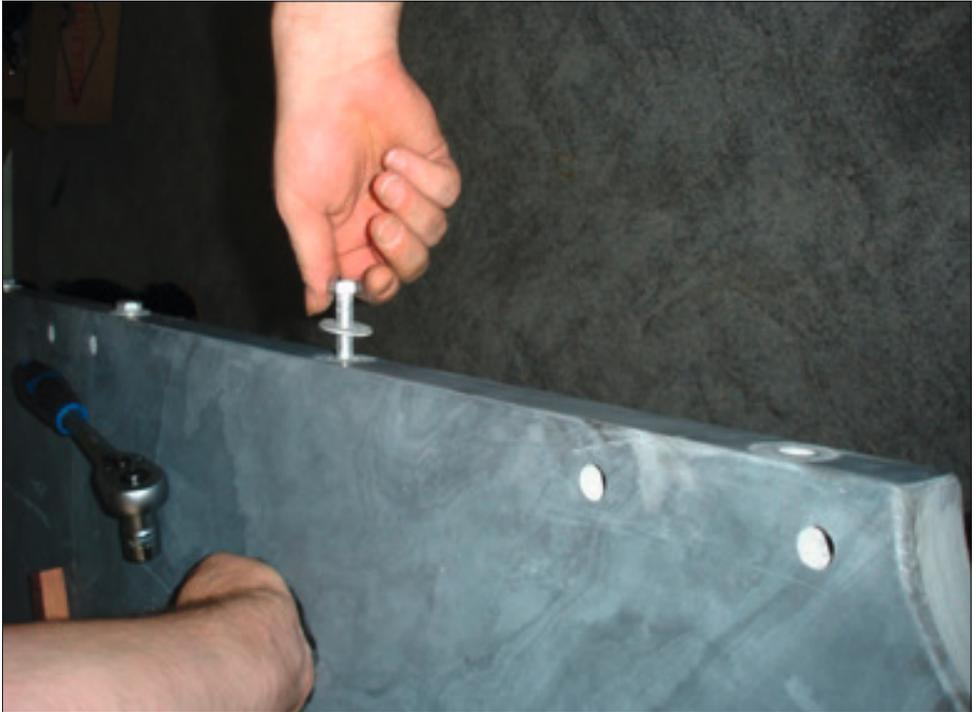
Lösen Sie die vorinstallierten Schrauben aus der Schieferplatte. Später werden diese Schrauben benötigt um die Banden zu befestigen.
