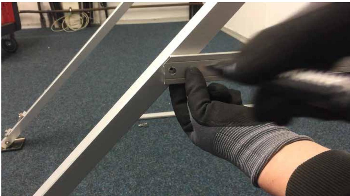
Markieren Sie nun die Position des zweiten Loches der Querstreben auf der Kollektorscheine und bohren an dieser Stelle ebenfalls ein Loch in die Kollektorscheine (siehe unteres Bild).
