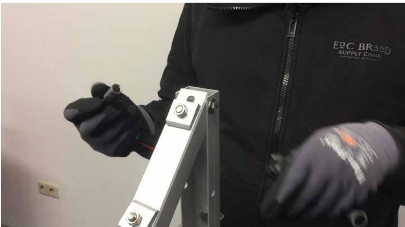
Verschrauben Sie beide Kollektorschienen nach dem Bohren am oberen Ende.
