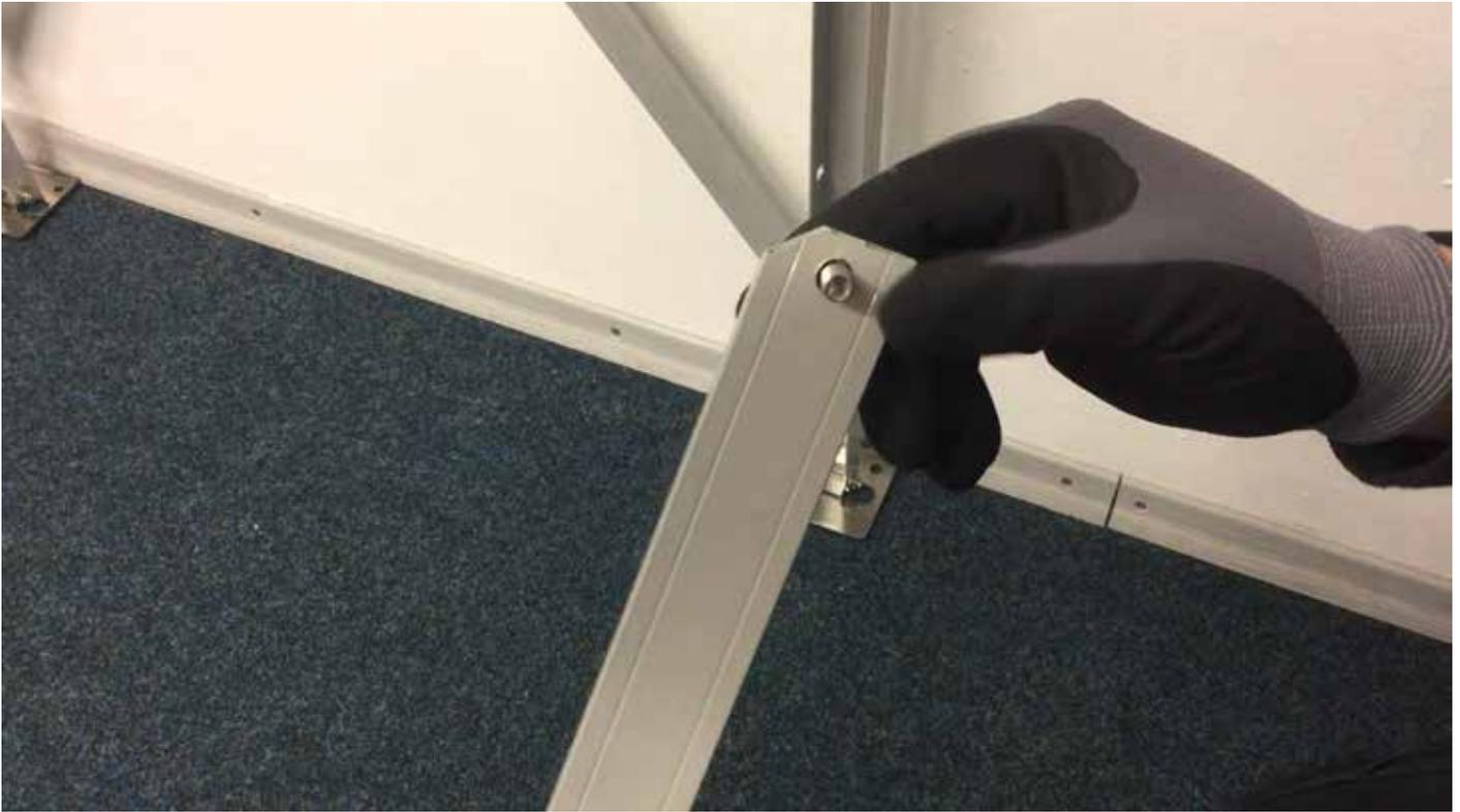
Nun müssen Sie die Stabilisierung Streben anbringen. Richten Sie dazu die hinteren Stellfüße im 90° Winkel zum Dach aus und verschrauben an dieser Seite die Querstrebe mit dem Rahmen.
