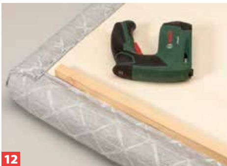
12 ... gleichmäßiger Spannung anheften. Die Ecken müssen Sie sauber und immer in eine Richtung einschlagen und feststackern.
