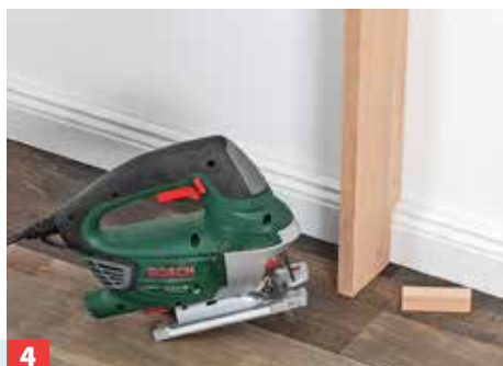
4 Damit die Ständer flach an der Wand stehen können, klinken Sie sie unten für die Sockelleisten sauber aus.
