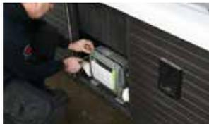
Um an die Platine zu gelangen, entfernen Sie die Abdeckung des Powerpacks.
