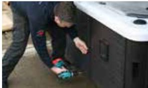
Entfernen Sie die das Panel der Frontverkleidung
