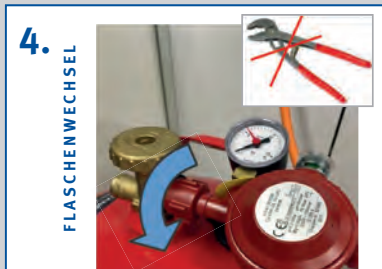
4. FLASCHENWECHSEL Druckregleinrichtung mit der Hand festschrauben – linksherum drehen, keine Zange benutzen
