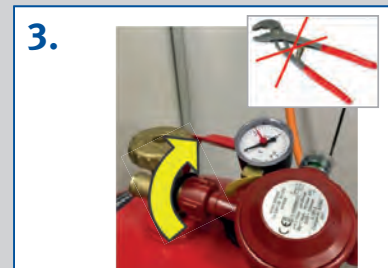
3. Jetzt mit der Hand Druckregleinrichtung abschrauben – rechtsherum drehen, keine Zange benutzen
