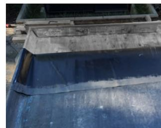
Es wird empfohlen, die Dachbahn vor der Verklebung zu kontrollieren. Evtl. können bei der Verlegung Beschädigungen durch spitze Gegenstände entstehen. In diesem Fall kann die Dachbahn mit Nahtabdeckband oder Formband und EPDM Aktivierung auf der Unterseite (und damit von oben nicht sichtbar) repariert werden.
