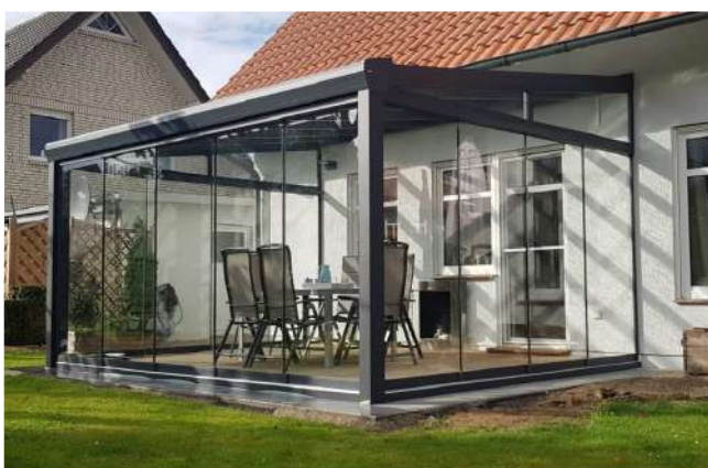
Keilfenster und Schiebetüren
