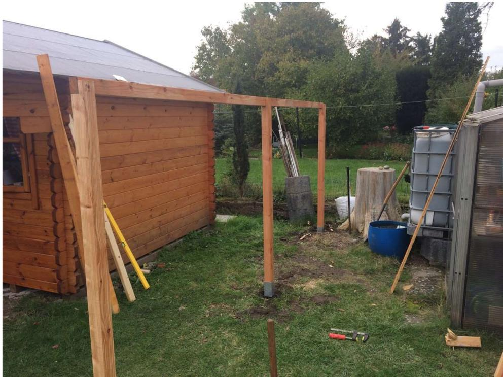
Die Stützen können in die Erde eingebracht oder auf Einschlaghülsen aufgeschraubt werden. Sobald die Konstruktion aus Stützen und Sattelbalken parallel zum Gartenhaus steht und waage ist können die Sparren Pos. 4 aufgeschraubt werden (jeweils auf Pfette und am Gartenhaus anschrauben). Sie können die Pfosten individuell einkürzen und damit den Winkel Ihres Schleppdachs selbst bestimmen.
