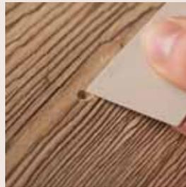
Scharfe Schadensränder mit der Spitze des braunen Schiebers abrunden, so dass ein weicher Übergang zur Fläche entsteht.
