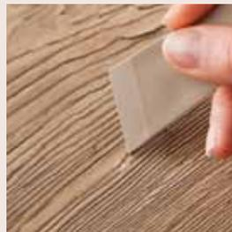
Maserungen mit Hilfe des braunen Schiebers und flüssigem Füllstoff nachzeichnen. Farbnuancen können durch Mischen der verschiedenfarbigen Füllstoffstangen erzielt werden. Füllstoff in den Schaden einbringen und Überstände abtragen. Je nach Belag und Oberfläche können so individuelle Strukturen und Maserungen nachgeahmt werden.
