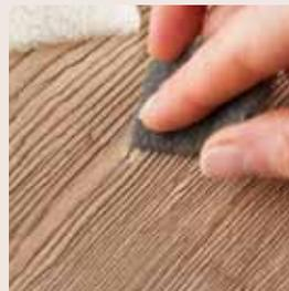
Durch leichtes, vorsichtiges Reinigen mit dem grauen Vlies den Schmierfilm auf der Fläche beseitigen und instandgesetzte Stelle mattieren. Nicht zu fest in Richtung des Schadens reiben, da sonst eine Unterfüllung entsteht.
