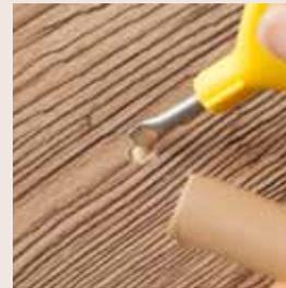
Heiße Spitze in Füllstoff eintauchen, so dass eine geringe Menge anhaftet. Wenn der Füllstoff an der Spitze qualmt ist dieser zu heiß. Knopf loslassen und Spitze leicht abkühlen lassen. Anhaftende Menge des Füllstoffs in das Loch geben. Vorgang wiederholen bis die Beschädigung vollständig gefüllt ist. Dabei sollte eine leichte Überfüllung entstehen
