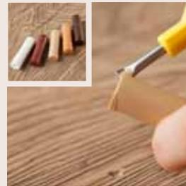
Farbauswahl der Füllstoffstangen entsprechend der Oberfläche auswählen. Mit dem zum Boden passenden hellsten Farbton befüllen. Durch Mischen der einzelnen Wachsstangen lassen sich die Farben variieren.
