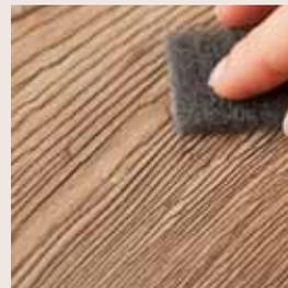
Glanzgradanpassung (mattieren) durch leichtes Reiben mit dem grauen Vlies vornehmen. Leichtes Reiben mit dem weißen Vlies lässt die Stelle ein wenig mehr aufglänzen.
