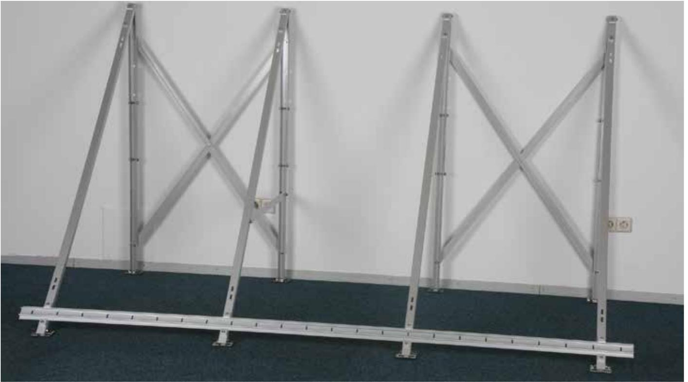
Richten Sie nun mittels der unteren Querschiene des Kollektors Ihre Halterungen aus. Achten Sie dabei darauf, dass die hinteren Stellfüße im 90° Winkel zum Dach liegen und befestigen Sie nun die restlichen drei Querstreben
