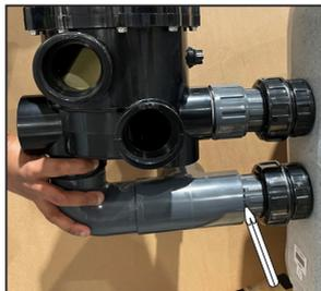
Sicherstellen, dass Mehrwegeventil waagrecht ist. Am unteren Rohr markieren, falls nötig, wie weit es später beim Einkleben eingeschoben werden muss.
