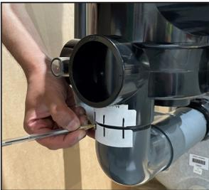
Drei senkrechte Striche über die beiden Abdeckbandstücke ziehen. Beim Kleben der Verbindung dann sicherstellen, dass diese Striche übereinstimmen.
