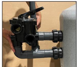
Sicherstellen, dass Mehrwegeventil waagrecht ist.
