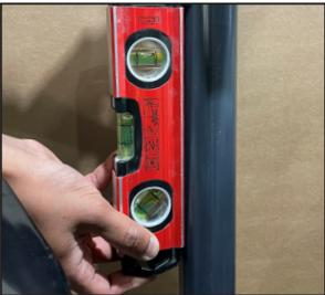
Mit Richtwaage prüfen, ob Gebläserohr senkrecht ist.
