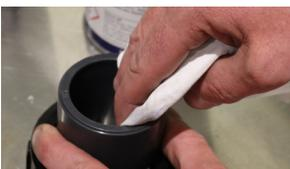
*Rohr zuerst reinigen*
