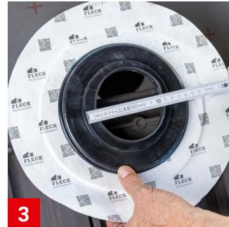
3 Prüfen, ob die Unterspannbahn-Dichtmanschette<sup>2</sup> und der Durchmesser des Anschlussstutzens zueinander passen.
