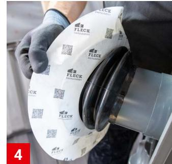
4 Unterspannbahn-Dichtmanschette über das Unterrohr führen.
