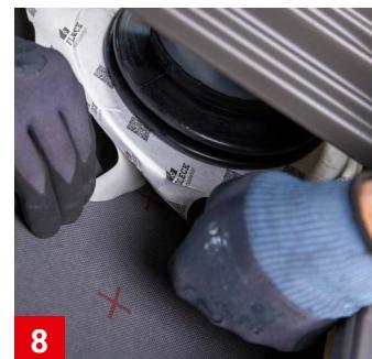
8 Unterspannbahn mit Unterspannbahn-Dichtmanschette verkleben, indem die rückseitige Schutzfolie entfernt wird<sup>3</sup>.
