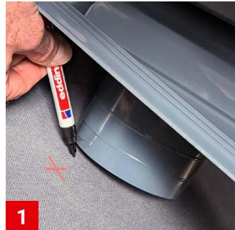
1 Anschlussstutzen des Sani Extras auf die Unterspannbahn setzen und finale Position anzeichnen<sup>1</sup>.
