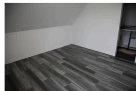
Den Rest des Raumes nach gleichem Prinzip verlegen.
