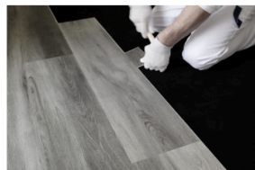
Die Dielen werden einfach per Hand eingesteckt. Die richtige und endgültige Position einer Diele wird mit Hilfe von Keil & Gummihammer erreicht.
