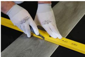
Die letzte Diele einer Reihe muss in der Länge angepasst werden. Dafür den benötigten Abstand abmessen, auf der Diele markieren und mit Hilfe einer Wasserwaage, oder eines Winkels und Cuttermessers, einen geraden Schnitt ziehen.
