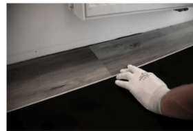
Die Montage beginnt in der linken Ecke. Die erste Diele wird mit der überlappenden Seite in Richtung Wand platziert. Die nächste Diele wird ganz einfach an die erste Diele angesetzt und der Stoß wird mit dem Gummihammer angeklopft.
