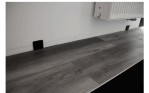
Die zweite Reihe sollte wie abgebildet mind. 20 cm versetzt verlegt werden, um einen möglichst schönen Effekt zu erzielen. Der Abstand zur Wand sollte 6-8 mm betragen.
