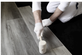
Der Stoß der Längsverbinding wird per Hand eingeklickt oder leicht mit einem Gummihammer eingeklopft.
