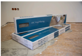
Den SPC Vinylboden zum Verlegen vorbereiten.
