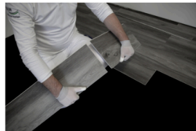
Anschließend die Dielen mit Hilfe einer Kante z.B. Knie, brechen und das letzte Stück in die erste Reihe einfügen.
