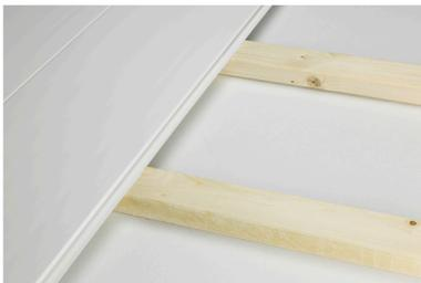
1. Dachlatten mit 30-40 cm Abstand an der Wand oder der Decke anbringen.
