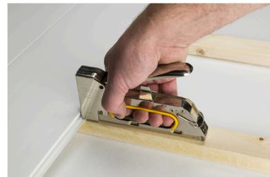
2. Die Paneele werden an der Feder mit dem Tacker an die Dachlatten befestigt.
