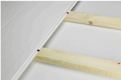
3. Das nächste Paneel in die Nut einstecken und wie im zweiten Schritt den Vorgang wiederholen.
