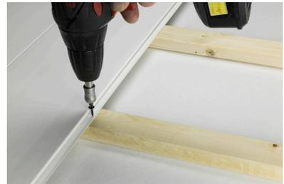
2. Die Paneele werden an der Feder mit Schrauben befestigt.
