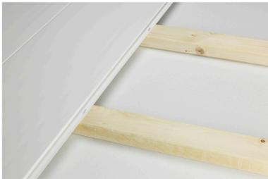
3. Das nächste Paneel in die Nut einstecken und mit gleicher Methode wie im zweiten Schritt wiederholen.
