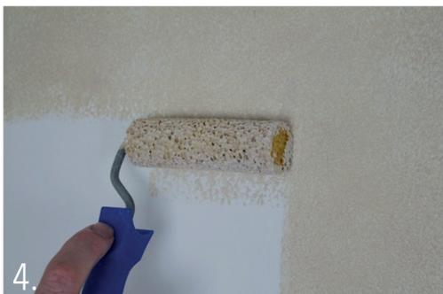
4. Den Kraftkleber mit Pinsel oder Walze auf den Untergrund auftragen und ca. 10 Minuten bei normaler Zimmertemperatur warten um den Kleber zu entlüften.
