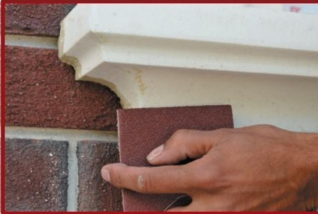
17. Nach vollem Abtrocknen, schleifen Sie die Überreste der Spachtelmasse ab.
