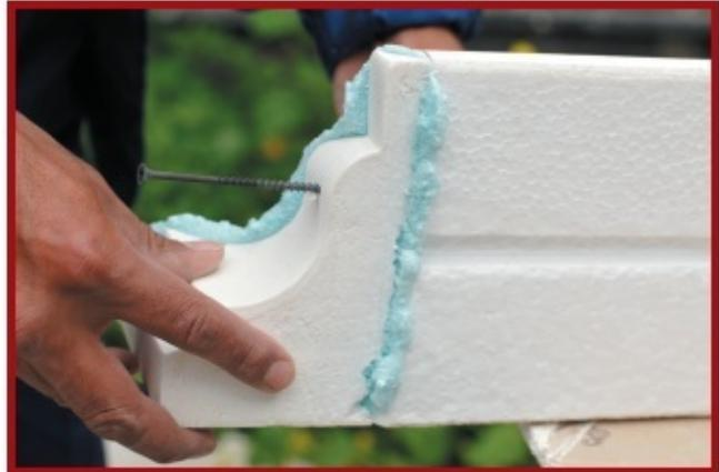
14. Fixieren Sie die geklebten Elemente mit einer Schraube.
