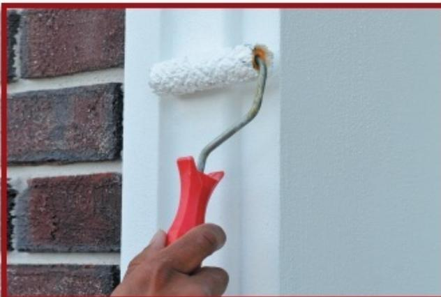
19. Die fertigen Fassadenelemente können jetzt nach Wunsch mit dekorativem Putz beschichtet oder mit Fassadenfarben gestrichen werden.
