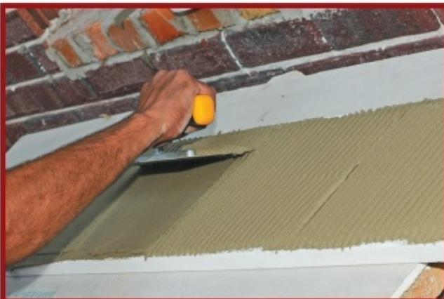
3. Den Armierungsmörtel mit Zahnpachtel auf die beklebende Fläche des Fassadenelements auftragen.
