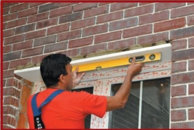
5. Überprüfen Sie mit einer Wasserwaage die horizontale Lage des geklebten Elements.
