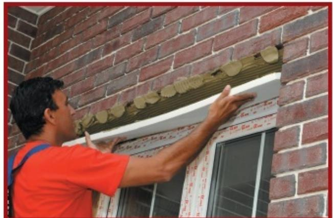
4. Das Fassadenelement an die Wand pressen, bis der ganze Klebstoff einen sicheren Kontakt mit der Wand hat.
