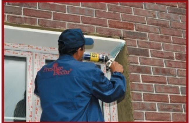
6. Tragen Sie auf die Stoßverbindung der Elemente den Schaumstoffkleber bzw. Montagekleber auf. Die Erstarrungszeit des Klebers muss berücksichtigt werden.
