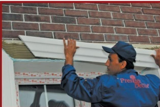
11. Bringen Sie die Elemente an die Verarbeitungsflächen an. Stoßstellen mit Schaumstoffkleber bzw. Montagekleber füllen.
