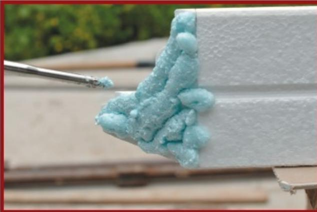
13. Der Schaumstoff- bzw. Montagekleber soll vollständig auf die beklebende Fläche aufgetragen werden.
