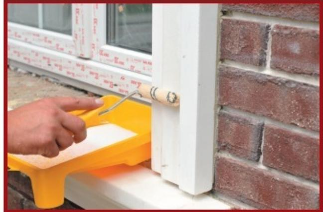
18. Alle montierten Elemente grundieren.
