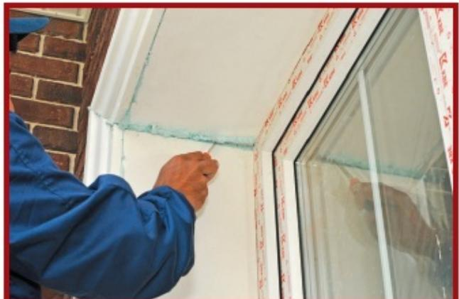
12. Nach vollem Abtrocknen des Klebers, die Reste abschneiden und verbleibende Lücken schließen.
