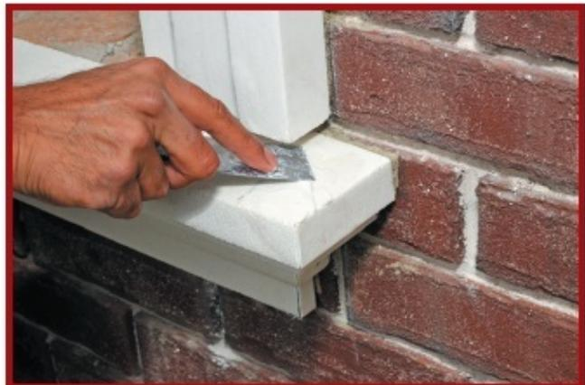
16. Fugen mit spezieller Spachtelmasse "DarMix" schließen.
