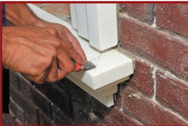
15. Nach vollem Abtrocknen, alle Fugen mit einer Breite und Tiefe von 2-3mm befreien.
