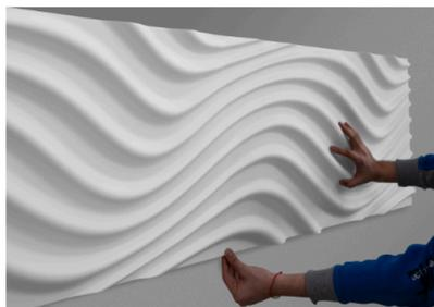
Nach selben Prinzip die Montage fortsetzen. Die Platten können versetzt oder aufeinander geklebt werden.
