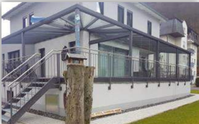
Erfordert präzises Arbeiten inklusive guter Vorbereitung im Bereich der Glasschneider.
