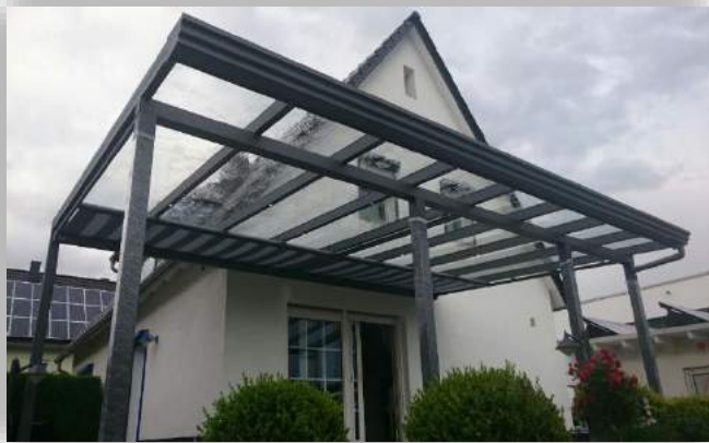
Pulldach mit 50cm Dachüberstand.
