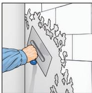
**1.** Der Untergrund muss trocken, tragfähig, sauber, gleichfarbig und glatt sein. Alte Tapeten und nicht haftende Beschichtungen entfernen. Raue Untergründe mit gipshaltigen Spachtelmassen glätten. Durch geeignete Grundiermittel für einen gleichmäßig saugenden Untergrund sorgen.
