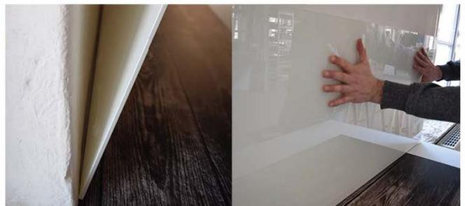
3. Stützen Sie nun die Platte gegen die Wand, am besten über Nacht, damit das Silikon gut anbindet. Als Letztes sollten Sie am Übergang zur Arbeitsplatte noch eine Silikonfuge ziehen, um das Eindringen von Schmutz und Wasser zu vermeiden. Bei dem Einbau in Nasszellen sollte die Abdichtung ringsum erfolgen.
