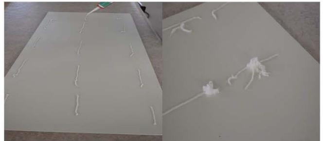
2. Stellen Sie nun die Platte auf die Arbeitsplatte/ Duschtasse etc. senkrecht auf und drücken Sie diese langsam und mit mäßigem Druck, von unten nach oben an der Wand fest. Je nach Größe der Rückwand, sollten Sie diesen Arbeitsschritt zu zweit ausführen.
