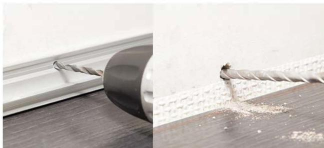
2. Schrauben Sie die Schienen an die Wand. Achten Sie darauf, dass alle Schrauben richtig versenkt sind.
